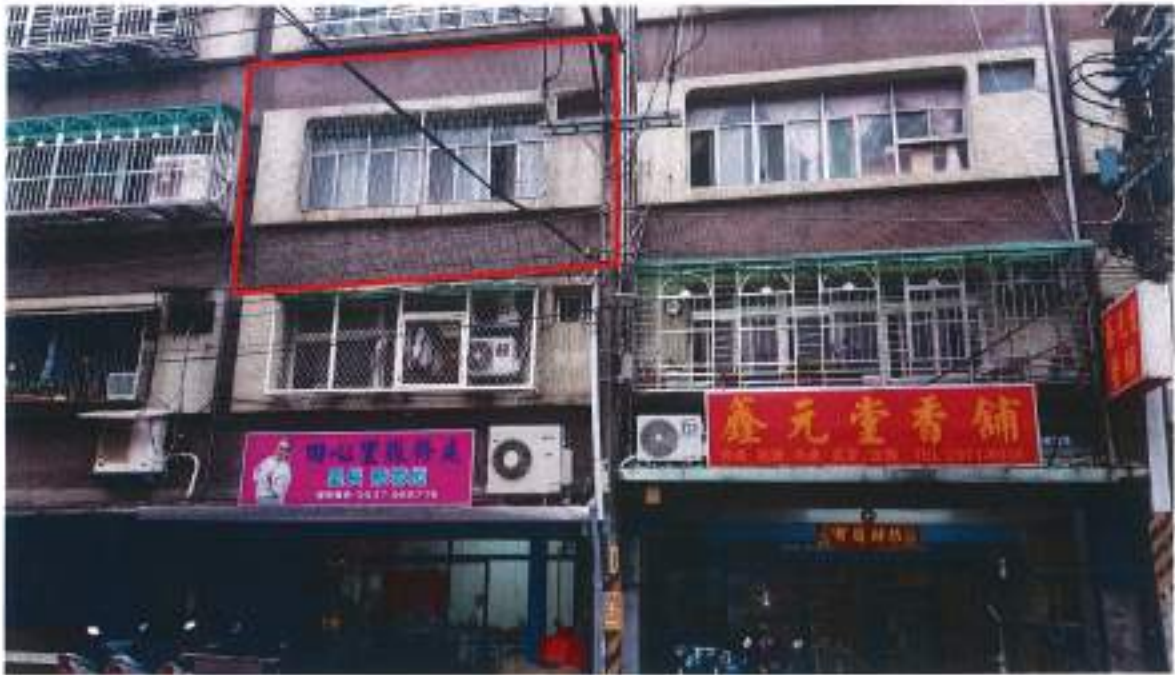
忠孝路3段50巷64號3樓現況照
