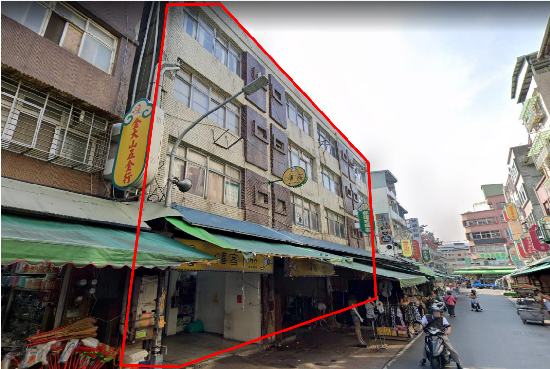
蘆洲區成功路 161 號現況照
