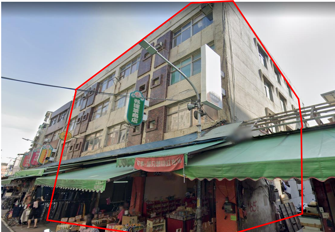
蘆洲區成功路 161 號現況照
